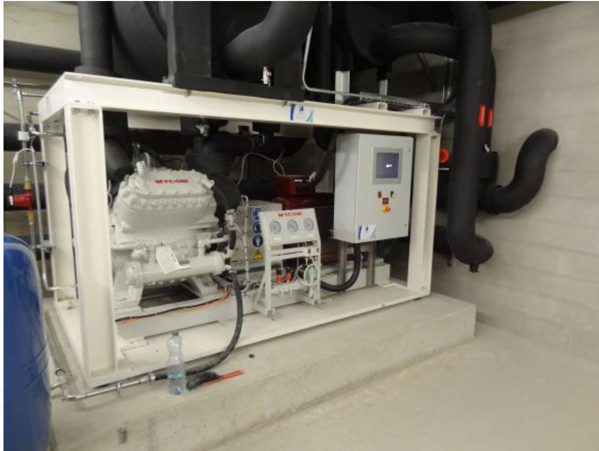
Wärmepumpe 560 kW
