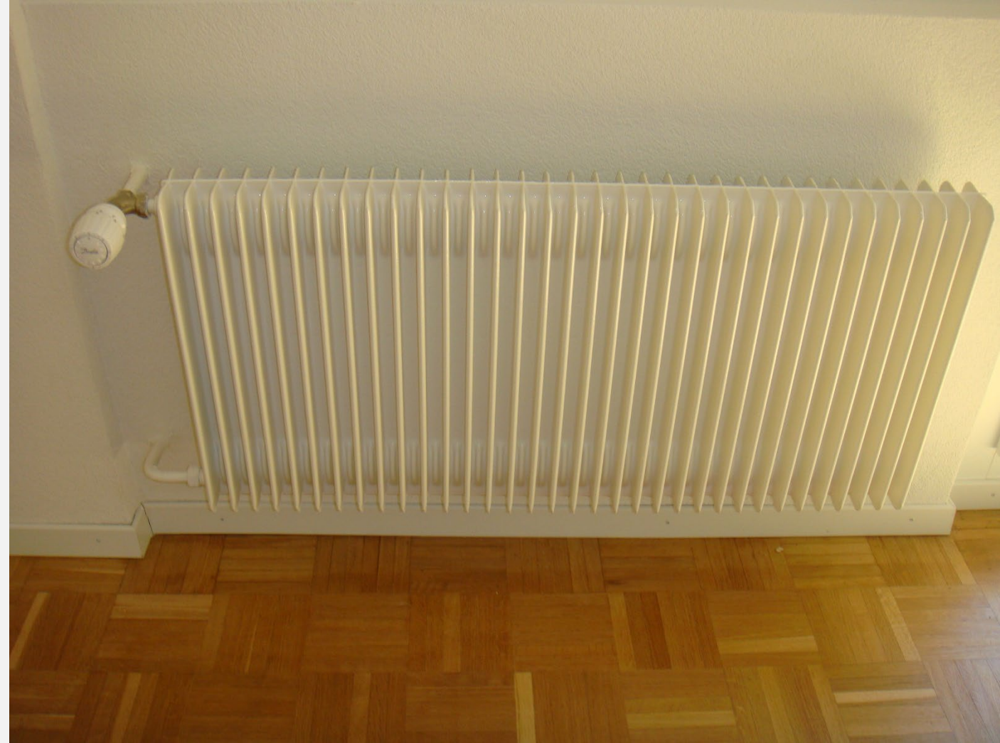
Neues druckabhängiges Vorlaufventil Danfoss RA-DV auf bestehende Heizkörper
