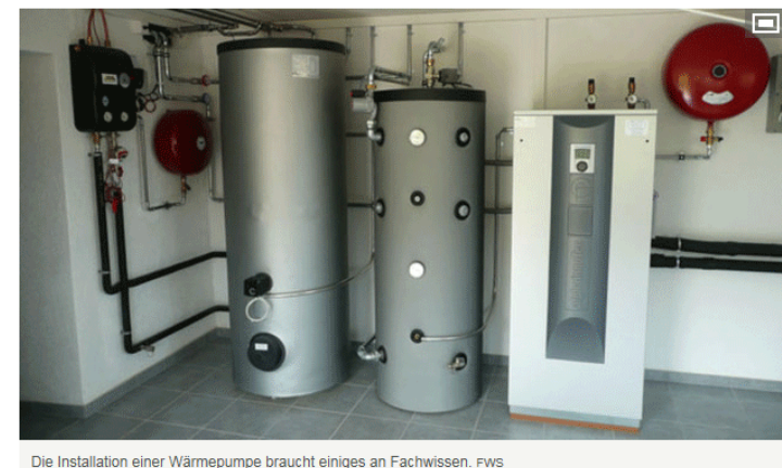
Die Installation einer Wärmepumpe braucht einiges an Fachwissen. FWS
