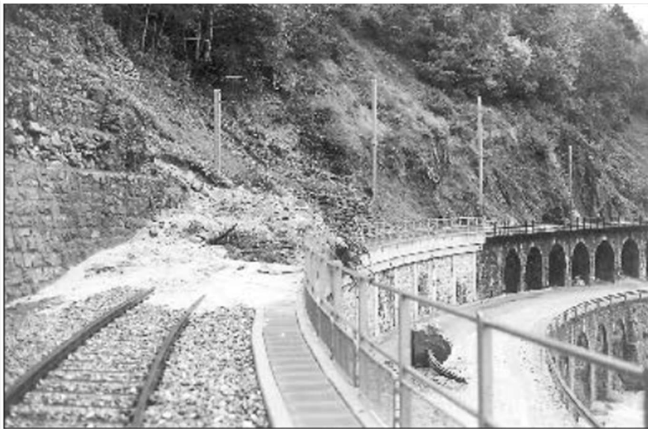
Bei Kilometer 9,55, zwischen Mörel und Betten-FO, bedeckt ein Hangrutsch Schiene und Strasse. Und von unten droht der Rotten.
