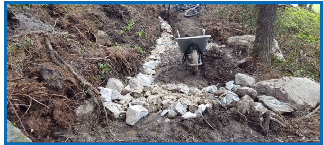
Bau einer Sickerpackung beim Moos-Trail, Zermatt (Foto: BikePlan AG)
