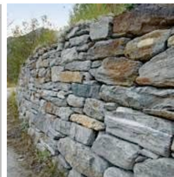
Bsp. Blocksteine (links) und Trockensteinmauer (Quelle: ASTRA, Schweizer Wanderwege, Handbuch)
