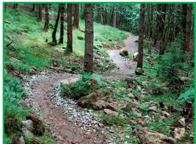
Beispiel eines Trails mit mehreren, dem Gelände angepassten Neigungswechseln (Quelle: IMBA)
