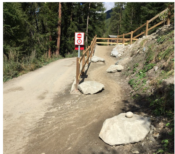
Aufwändige Schikane auf MTB-Piste vor einer Einmündung auf eine Forststrasse (Quelle: BikePlan AG > Sunnegga-Trail)
