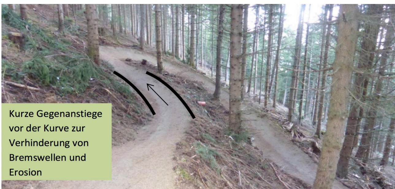
Empfehlung: Kurzer Gegenanstieg vor Kurven zur Verhinderung von Bremswellen und Erosion (Quelle: Tiroler MTB-Modell 2.0)
