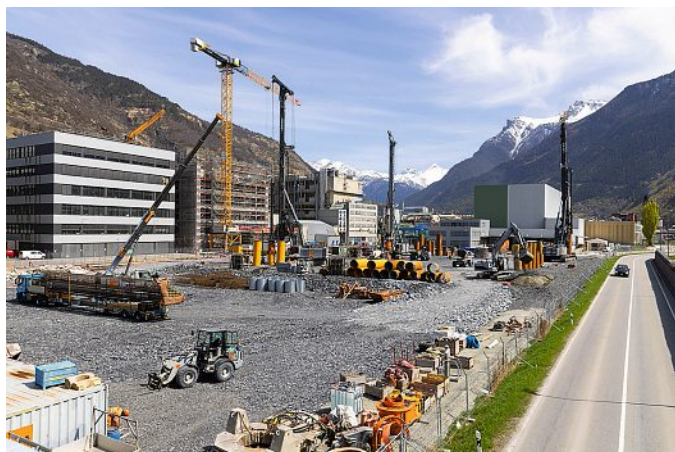
Visp im Wandel: Der alte Dorfteil von Visp (o.), Lonza-Baustelle, wo fünf neue Fabriken entstehen (u.).
